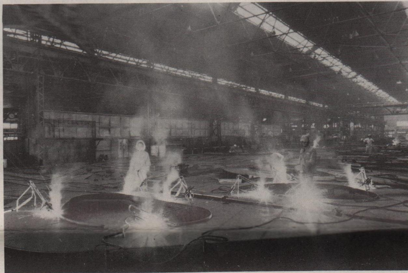
Un'applicazione del metodo di saldatura "gravity welding" (saldatura a gravità), estremamente diffuso nei cantieri giapponesi ed in corso di attuazione anche nei nostri cantieri.
