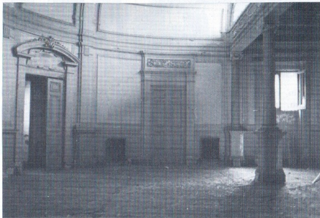
Un interno del Palazzo Farnese prima del «restauro».
