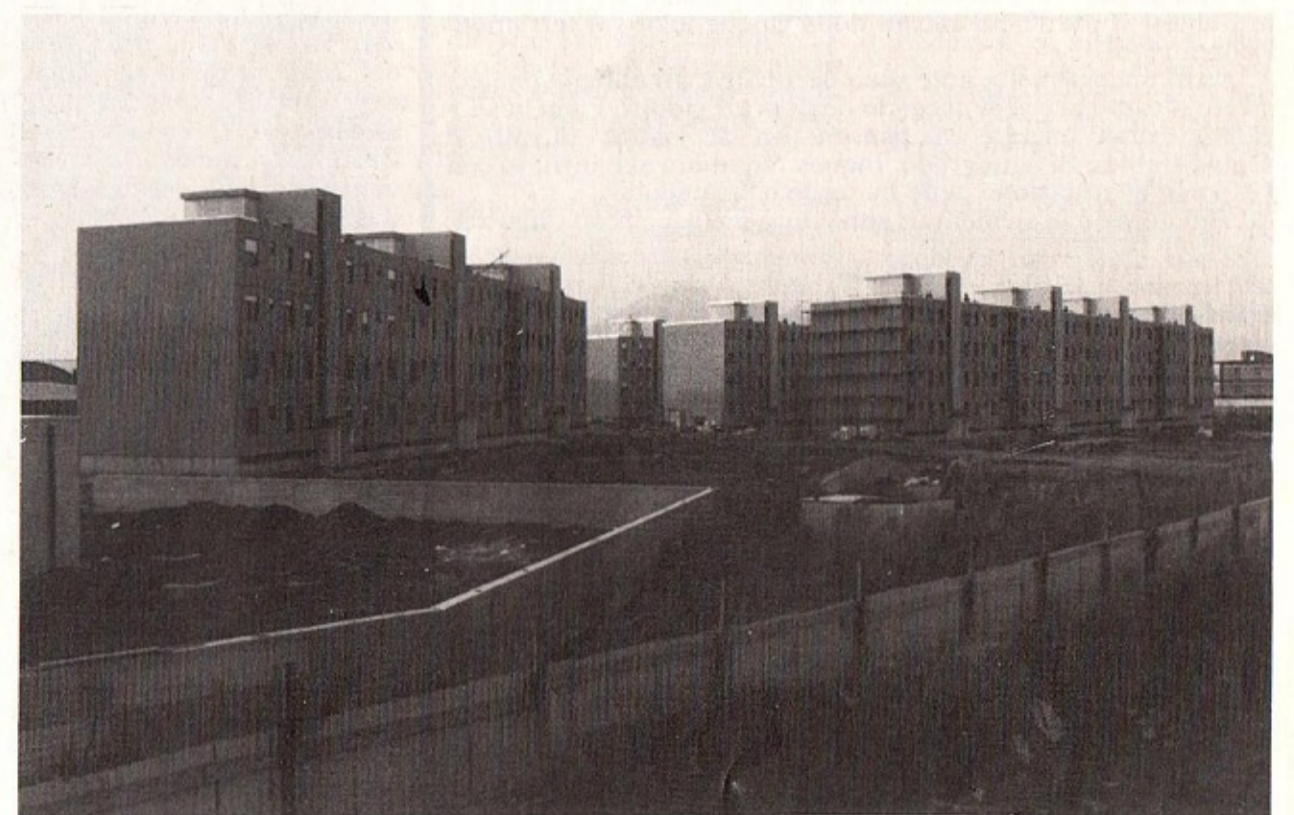
I 189 alloggi costruiti a Pioppaino.
