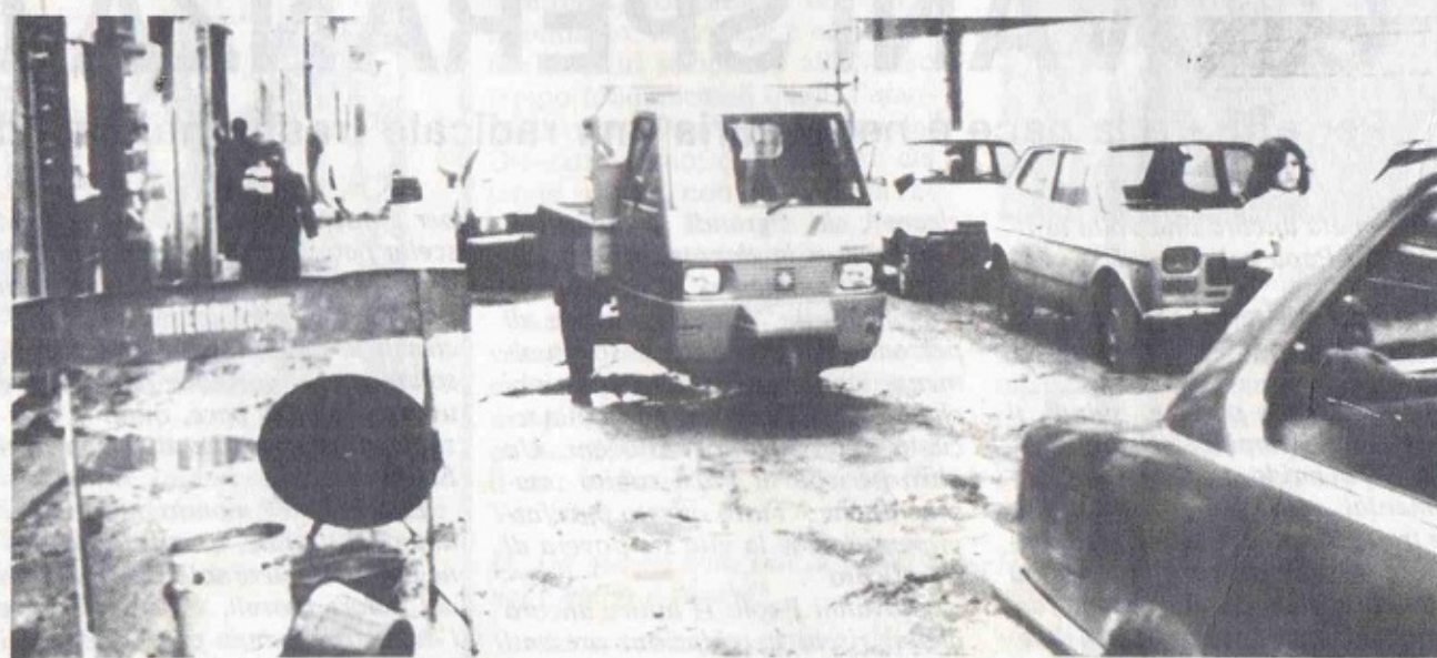
Lavori in corso a Via Regina Margherita (Foto di G. Lombardo)
