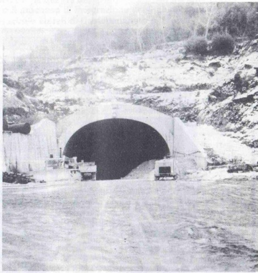
L'ingresso della galleria della variante sorrentina (foro Di Costanzo)
