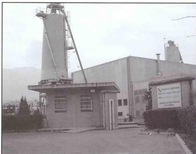
Depuratore di Foce Sarno
