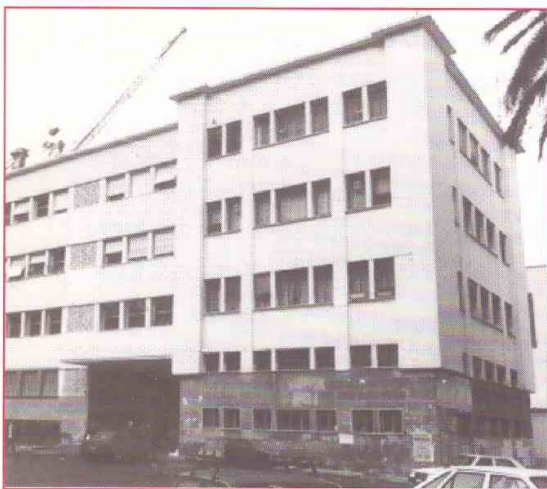
Lo stabilimento Fincantieri
