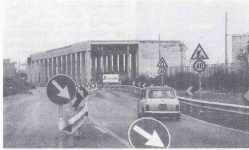
I lavori della variante sul Corso Italia all'altezza della stazione di Pioppaino della SFSSM. (Foto G. Lombardo)
